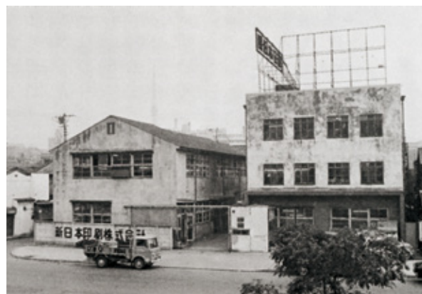
市ヶ谷工場全景
