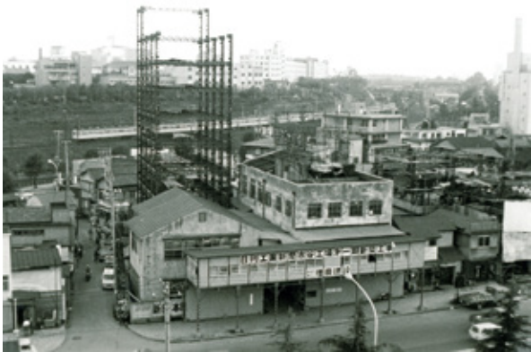
市ヶ谷工場工事全景
