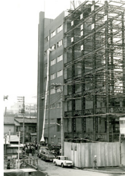
自衛消防演習における避難袋垂直降下訓練と第二期工事進捗風景
