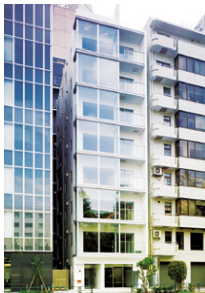
新日本市ヶ谷ビル全景
